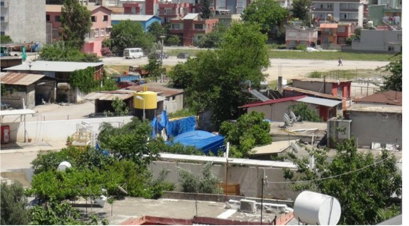
82 Evler Mahallesi’nde yapılan kazı birçok evin duvarlarının çatlamasına neden oldu.
